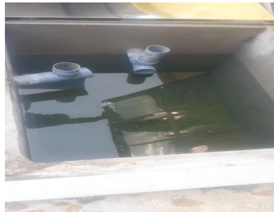
Hệ thống ống nước thải sinh hoạt trong cụm xử lý chung
