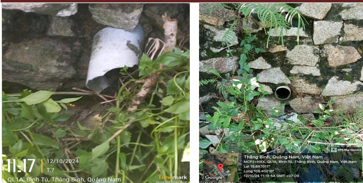
Hình 3.3. Hệ thống ống dẫn nước thải ra nguồn tiếp nhận
