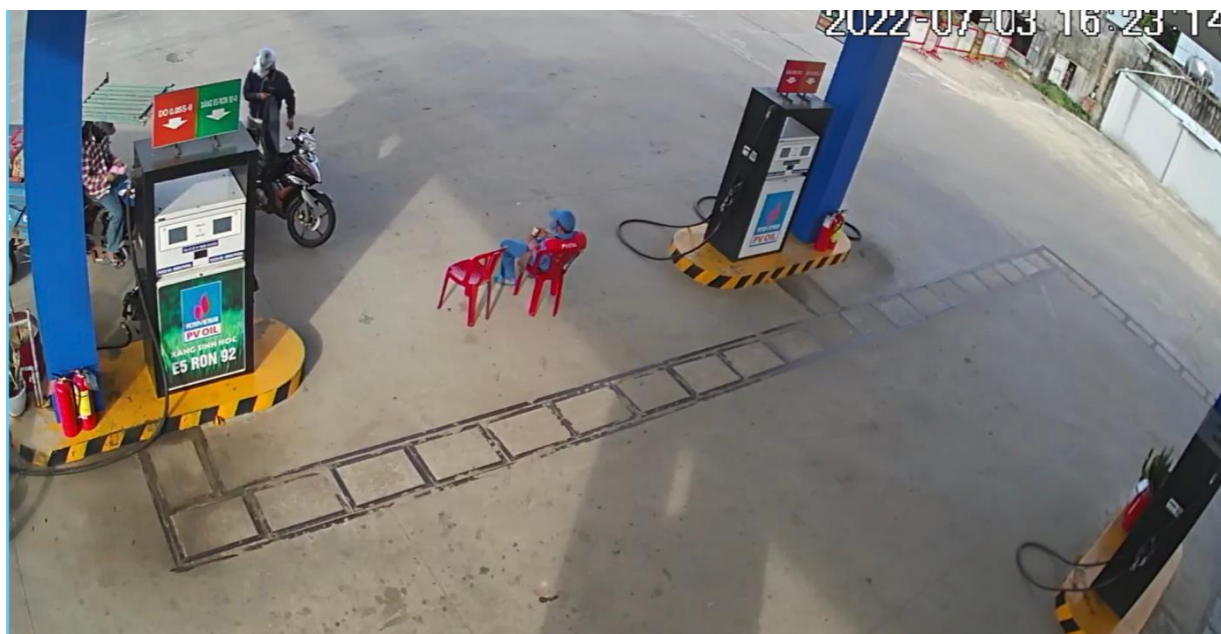
Hình 4. Sân bãi có độ dốc, mương gom nước mặt
