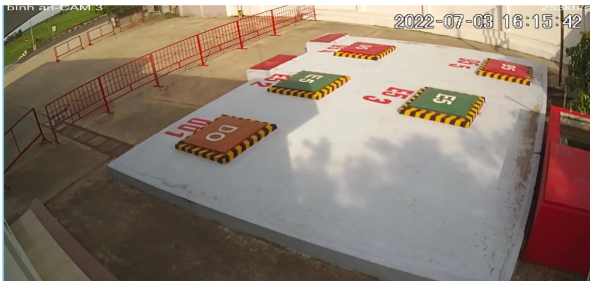
Hình 2. Bể chứa chôn ngầm bằng hệ thống nhập kín
